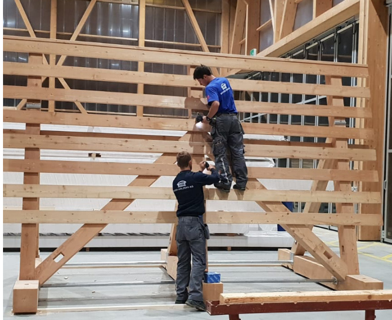
Gemeinsam für den Beruf: Lernende der Beer Holzbau AG aus Ostermundigen (BE) bauen mit den Lernenden der Uffer Holz AG aus Savognin (GR) an einer Schneeverwehungs wand.
